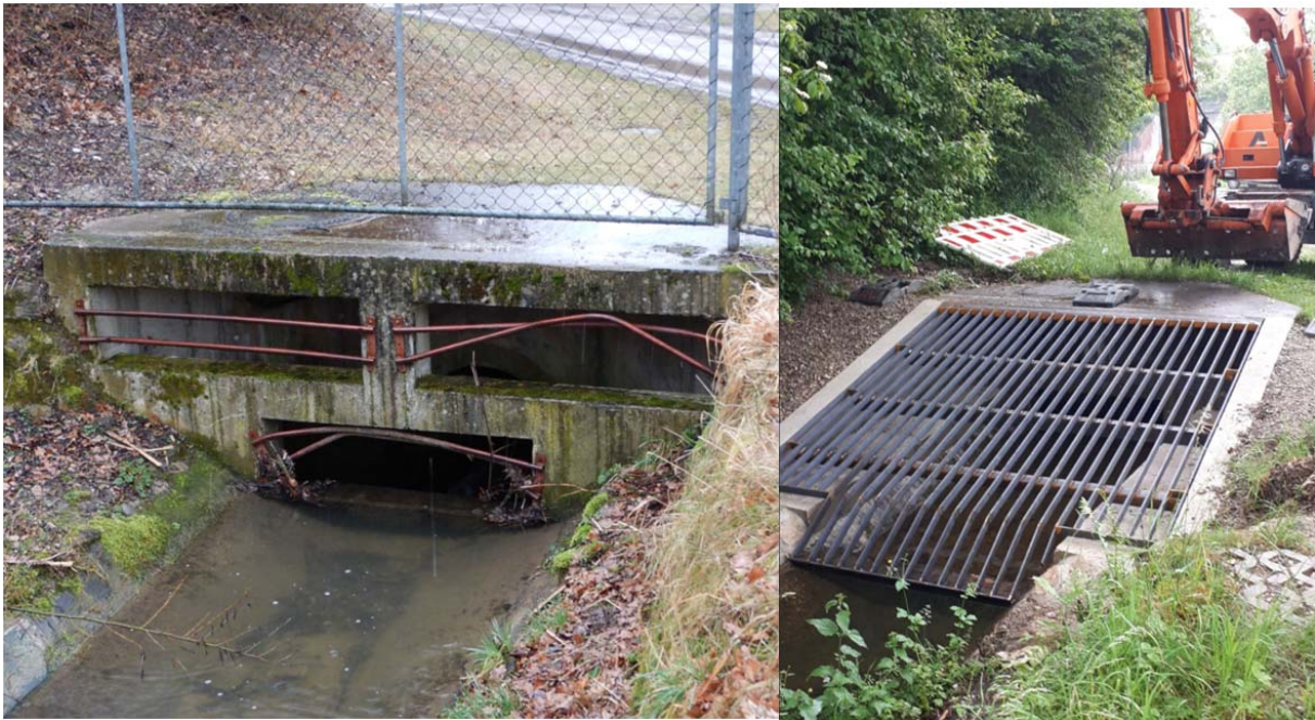
Abbildung 7.2: Einlaufbauwerk Harlachener Graben vor (l) und nach (r) der Sanierung
