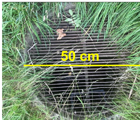
Abbildung 7.13: Ablauf in der Geländemulde in Breitötting
